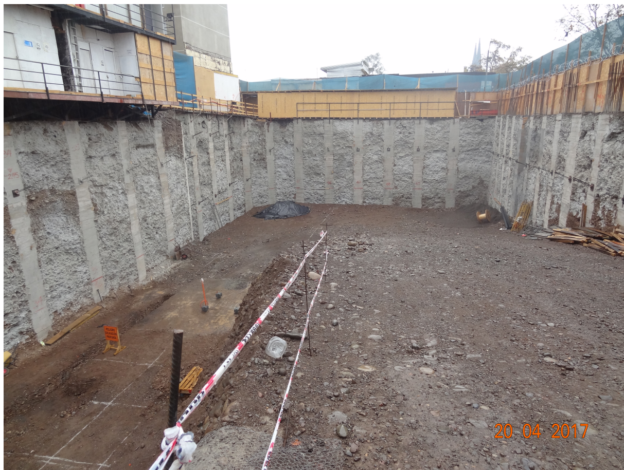
Fotografía N° 3: Vista Poniente, excavaciones, socializado y entibaciones.
